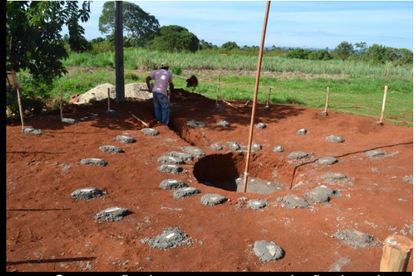
Construção do tanque para produção de peixes.
